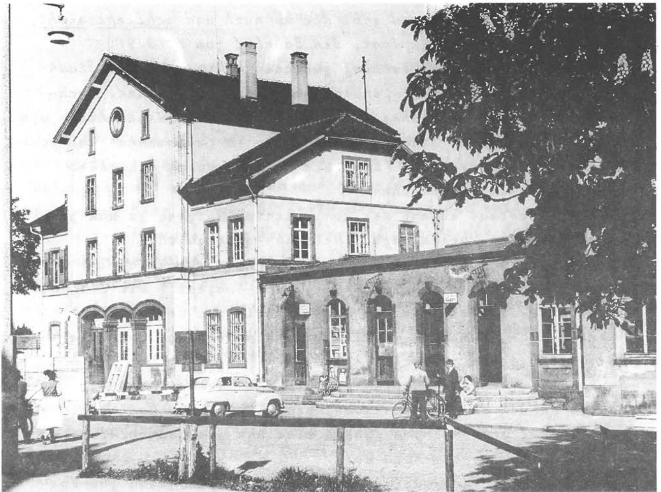
Den alte Bahnhof, kurz von dem Abriß
